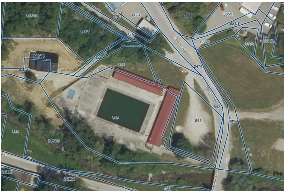
Slika 1: Območje obstoječega odprtega bazena
